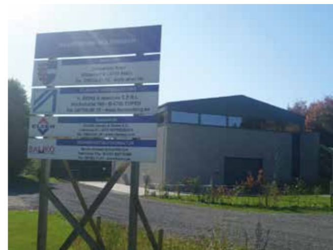
Das Wasserwerk Wolfsbusch
